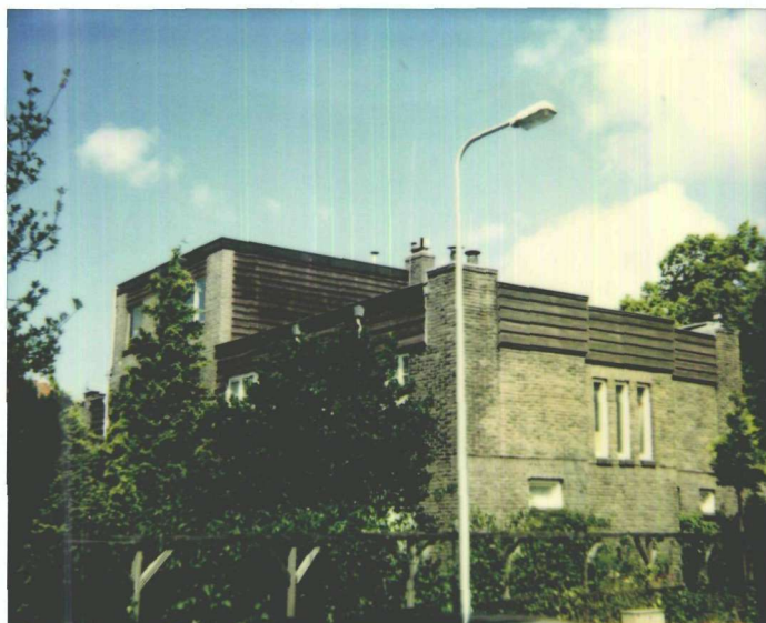
opbouw nr: 10 zij/achtergevel
